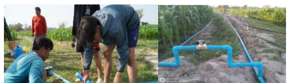
ภาพที่ 7 วางระบบท่อน้ำตามแนวแปลง
