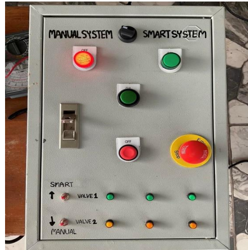
ภาพที่ 14 ไฟสถานะเมื่อปรับสวิตช์ลูกศรไปทาง Manual System
