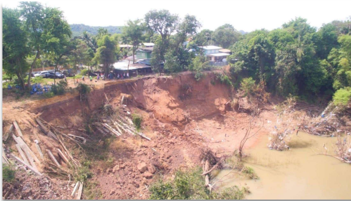
ภาพที่ 1 ปัญหาดินถล่มและการกัดเซาะที่ดินริมฝั่งแม่น้ำในพื้นที่ของชุมชนที่อยู่ติดแม่น้ำป่าสัก
