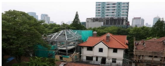
แผนภาพที่ 2 อาคารเก่าทางซ้ายมือถูกทุบเพื่อสร้างอาคารใหม่
