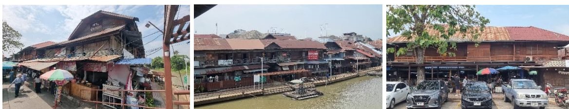
แผนภาพที่ 3-5 อาคารที่อยู่อาศัยและร้านค้าในตลาดสามชุก
