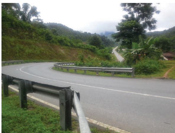
ถนนทางเข้าดานหินและตาน้ำปุ่น
