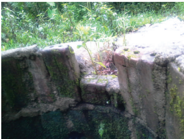
ทางส่งน้ำจากบ่อน้ำบุน
