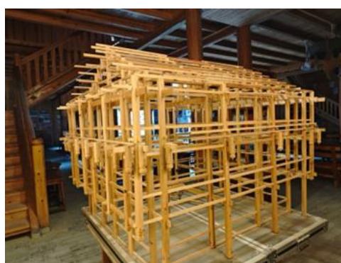
ภาพที่ 4 แบบจำลองโครงสร้างไม้บ้านยกสูง
