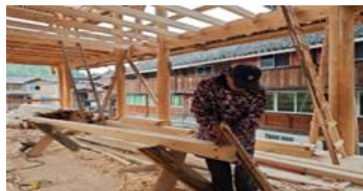
ภาพที่ 9 ขั้นตอนการก่อสร้างสถาปัตยกรรมที่อยู่อาศัยแบบดั้งเดิมตั้ง ที่มา : researcher
